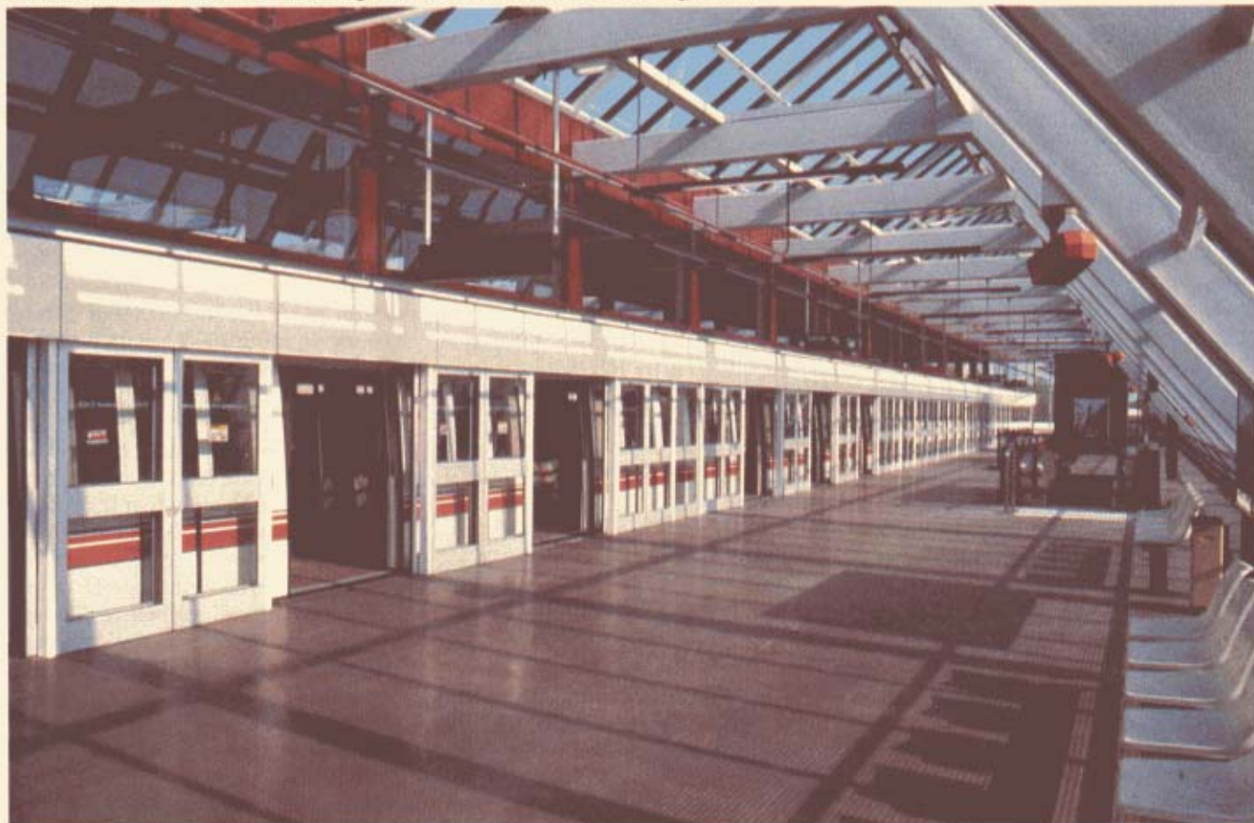
Les portes palières ne s'ouvrent qu'à l'arrêt du train.
